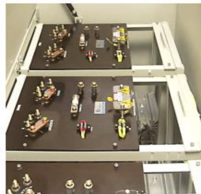
Vista superior rectificador especial 3 en 1, refrigerado por aceite.
