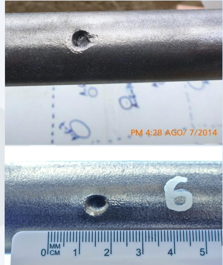
Fotos Fuente: 1er caso de corrosión AC determinado por TECNOLOGÍA TOTAL en Perú.
