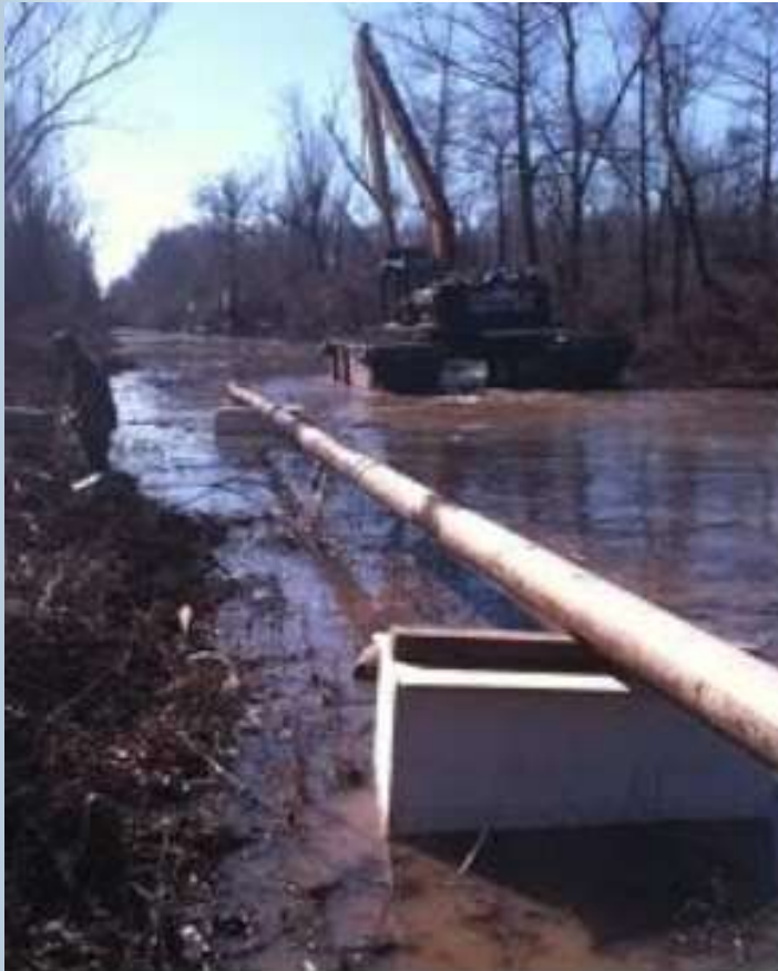
Levantamiento de línea de 8"
