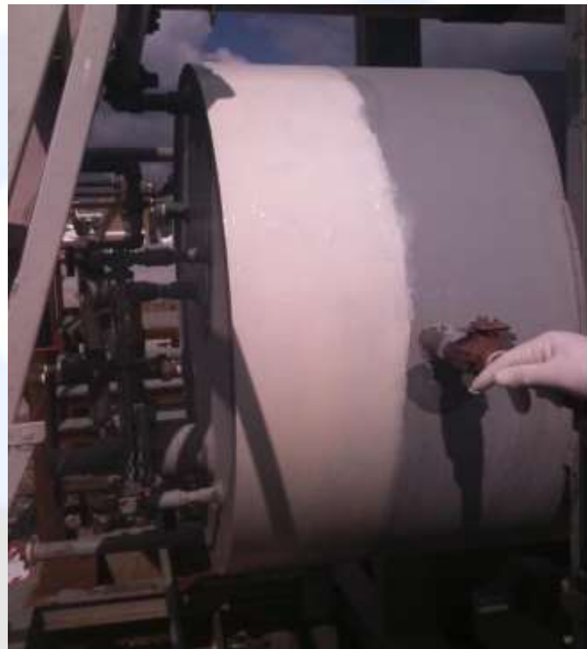
Aplicación de epoxico primario
