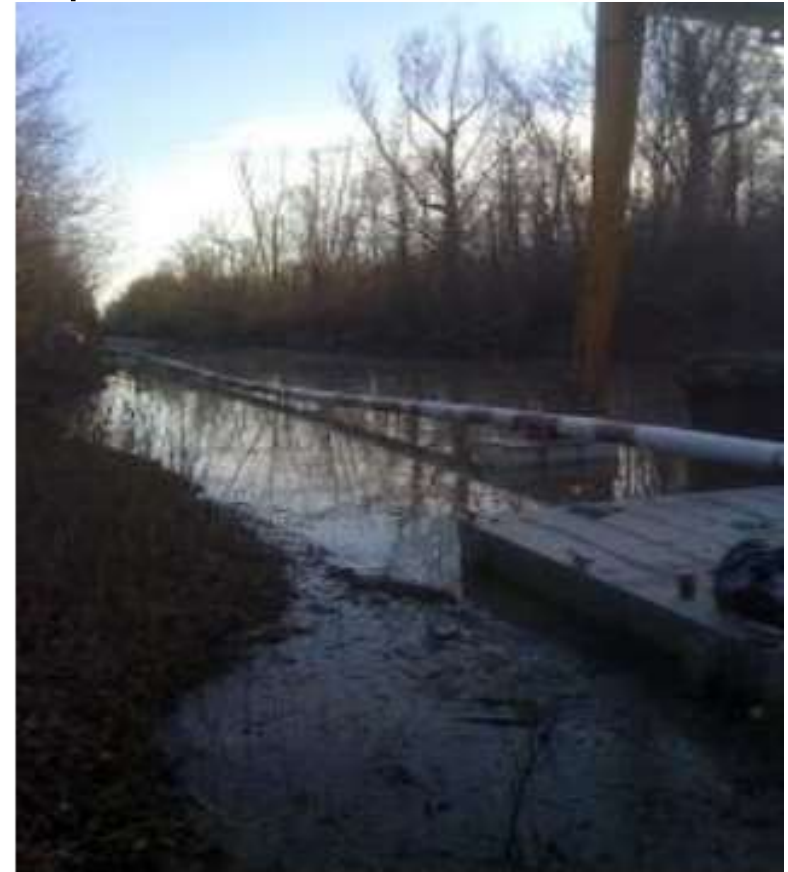
30 m reparados en 3 hrs
