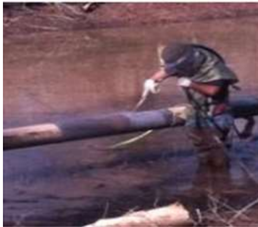
Preparación con chorro de arena
