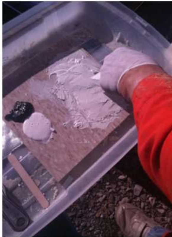
Mezcla del epoxico primario
