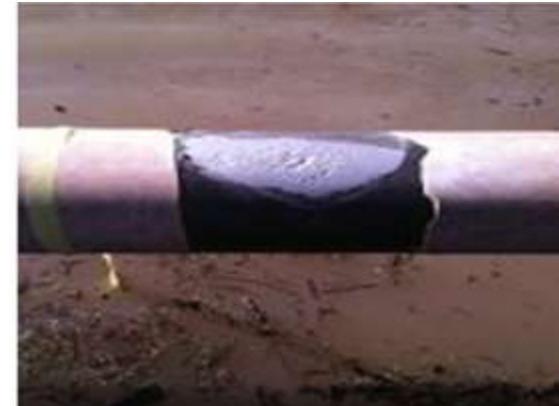
Aplicación de masilla de relleno
