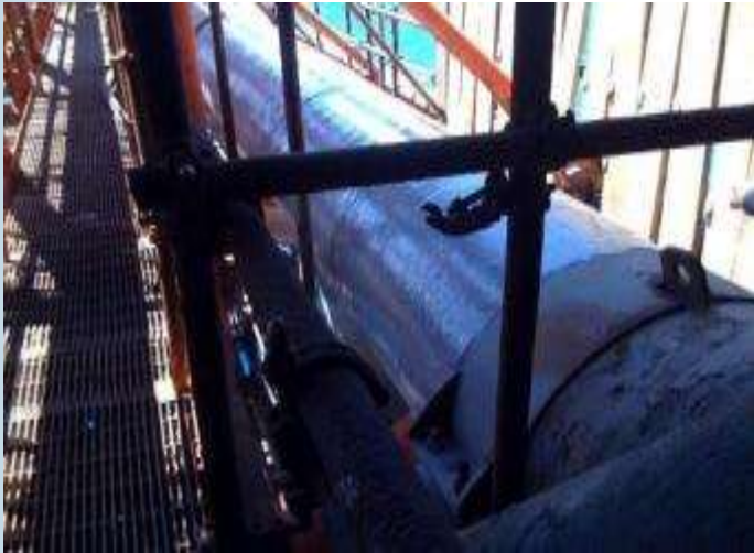
Heat-exchanger en una plataforma de BP reparado en el año 2009
