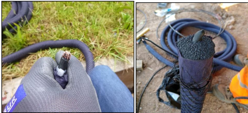
Figura 6. Empalme entre el alambre de cobre y el cable del ánodo, cubierto con cinta vulcanizante.
