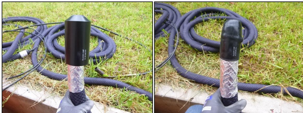
Figura 7. Colocación de la cinta de aluminio y la tapa termocontraíble.
